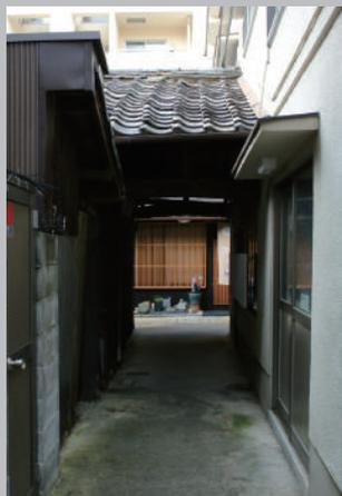
老朽化し雨漏りしていた屋根を撤去し、陽の入る明るい路地に。本体の屋根は重い瓦屋根から地震に耐え易い軽い板金の屋根に葺き替えられました。
