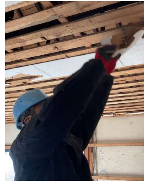
天井の石膏ボードをバールで落とす作業
