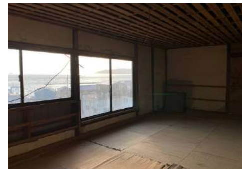
作業完了後の様子
