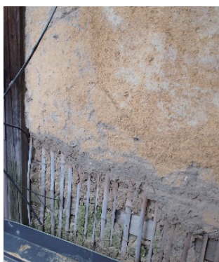
土壁の修繕：竹小舞を編み直し、土も塗り直します。
