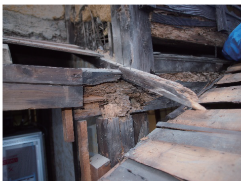
構造材の補修：腐朽した柱や梁の材を交換し、補強します。
