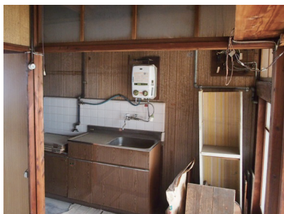
通り庭 : 床を張り直し、キッチン設備機器を交換します。
