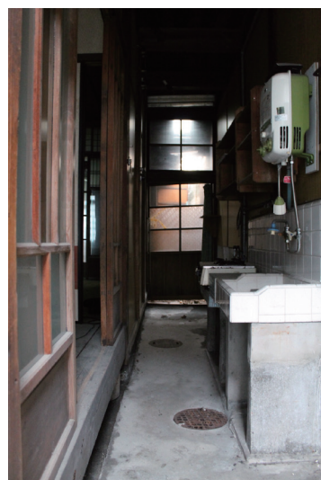
通り庭（改修前）
