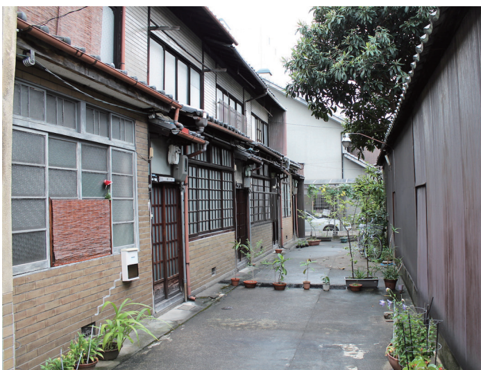
路地沿いの街並み（改修前）
