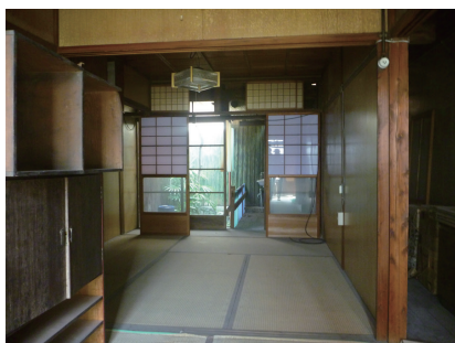
座敷 : 板で塞がれていた土壁を復元し、畳の表替え、板張りへの変更をします。
