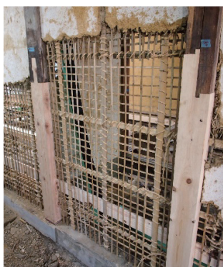
土壁の修繕：竹小舞を編み直し、土も塗り直します。
