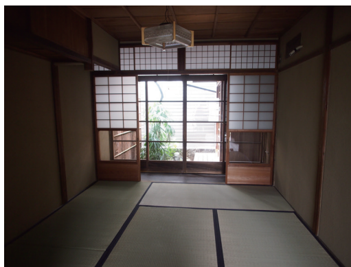
座敷 : 板で塞がれていた土壁を復元し、畳の表替え、板張りへの変更をします。
